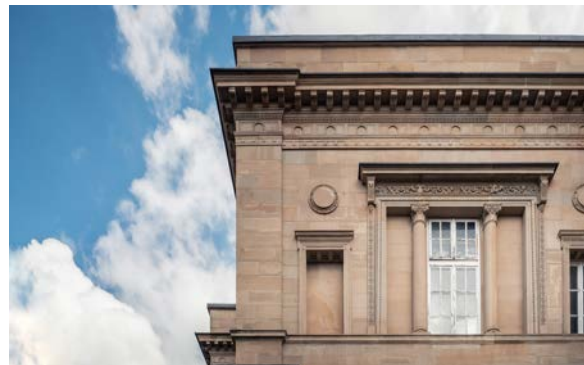
Villa Berg ATELIER BRÜCKNER
